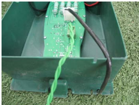
Bild 1.21 - Verlegung des Stromkabels von außen in die Haube
